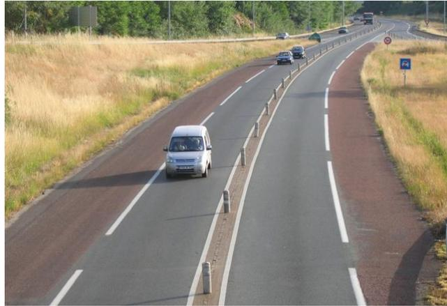
Figure 2: Aménagement d'un bande médiane équipée sur la déviation de Libourne
