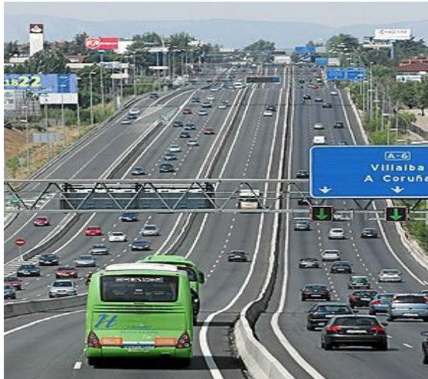
Exemple de la voie réversible et réservée BUS-VAO de Madrid : Portion à double sens de circulation sur terre plein central : 2 voies de largeur 3,50m bordées par une bande dérasée par sens de 0,50m, soit 8,00 m de plate-forme.
