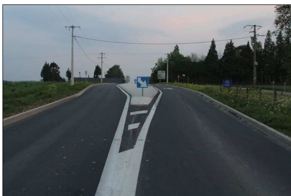
Illustration 13: Dissymétrie de l'îlot séparateur côté Yvetot.
