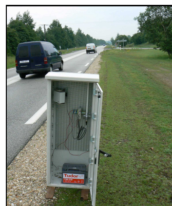
Figure 10 : boîtiers de détection sur les voies principales
