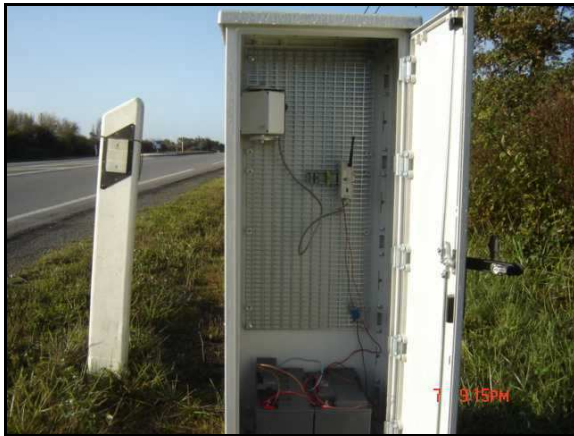
Figure 4 : armoire de détection des véhicules sur la voie principale
