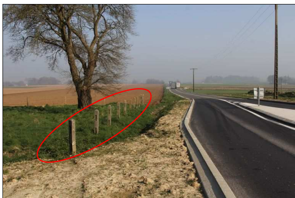
Illustration 19: Poteaux de barrières à déposer.
