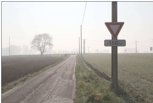
Illustration 24: Signalisation avancée du STOP non conforme : AB3b à remplacer par un AB5.
