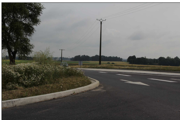
Illustration 35: Branche route de la Quenellerie : visibilité à gauche masquée par la végétation.
