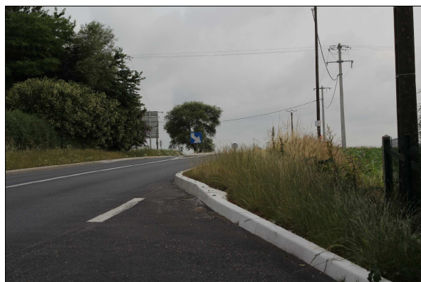
Illustration 38: accès riverain : visibilité à droite masquée par la végétation.
