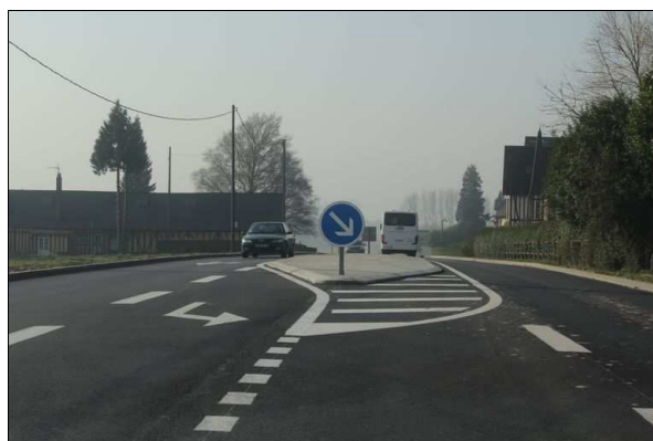
Illustration 18: Visibilité depuis la voie de TAG vers pont de Brotonne.
