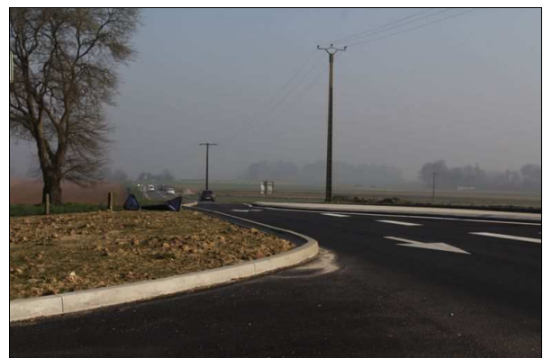
Illustration 40: Panneau EUROVIA couché par le vent. La visibilité à gauche est dégagée.
