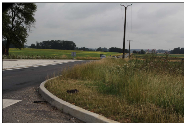
Illustration 34: Branche route du Vieux Louvetot : visibilité à droite masquée par la végétation.
