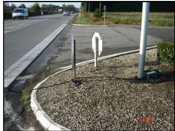
Figure 5 : boîtier de détection des véhicules sur la voie secondaire
