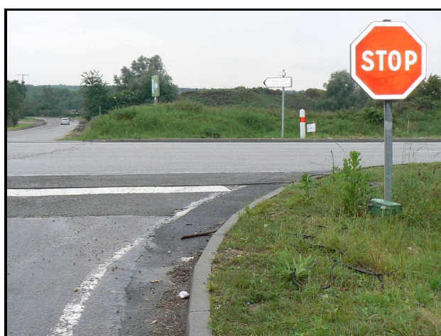
Figure 11 : boîtiers de détection sur les voies secondaires
