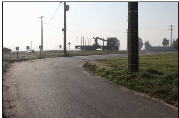
Illustration 25: Balisage de la courbe de type J4 monochevrons et poteaux béton proche du bord de chaussée.
