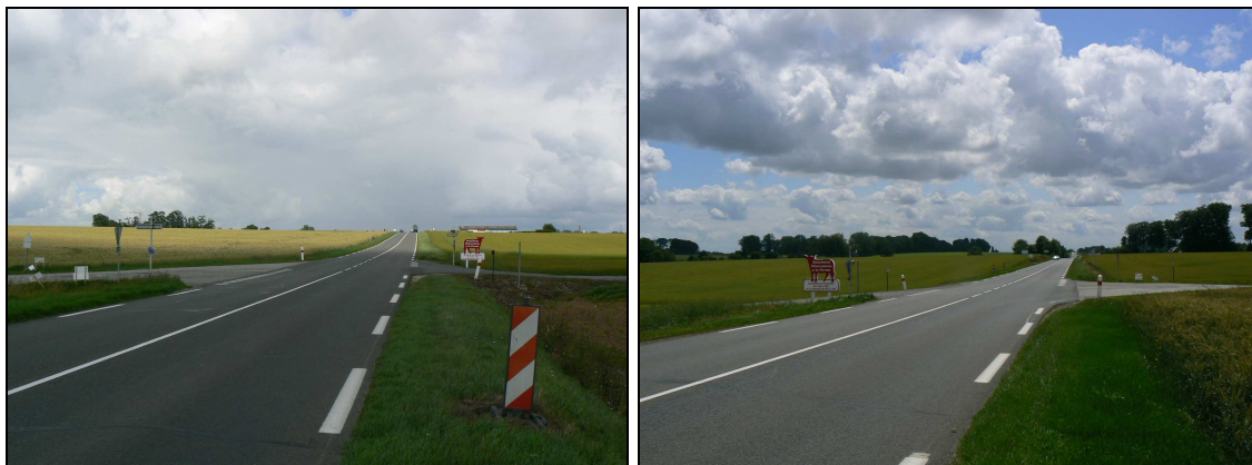
Figure 16 : photographies du carrefour RD131/VC2
