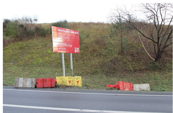
Figures A2-3 : Le diable se cache dans les détails ; D42 sur support fusible et création d'un obstacle pour la communication sur les travaux en cours
