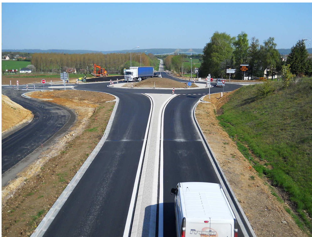
Photo 3 : Carrefour giratoire RD131-RD490 (source département de Seine-Maritime)
