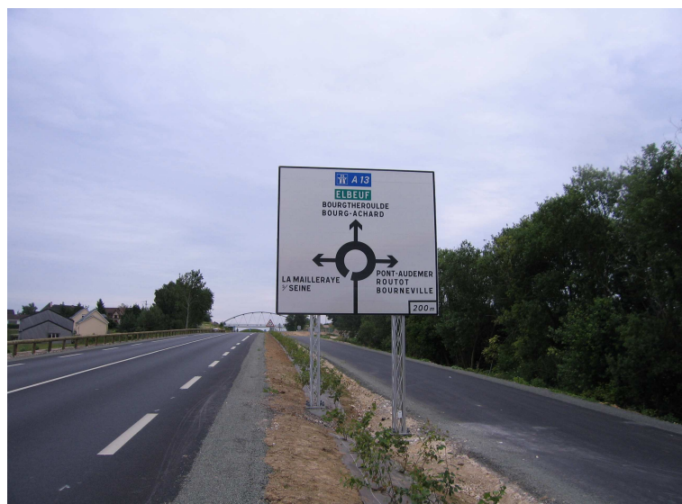
Figure A3-2 : Suppression des obstacles ;D42 sur support fusible
