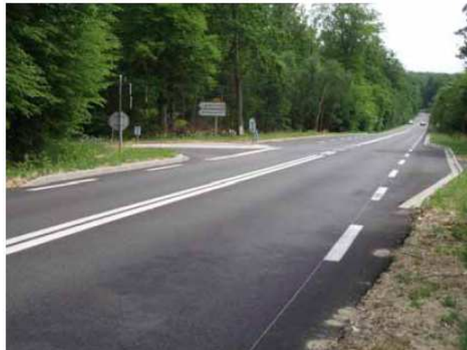
Figure A1-2 : Après aménagement : Îlots et voies sur la route principale
