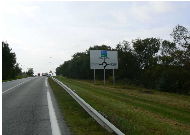
Figure A3-1 : D42 implanté derrière dispositif de retenue
