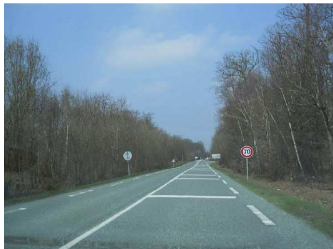
Figures A1-3 : Après aménagement : Bandes rugueuses et limitation de vitesse
