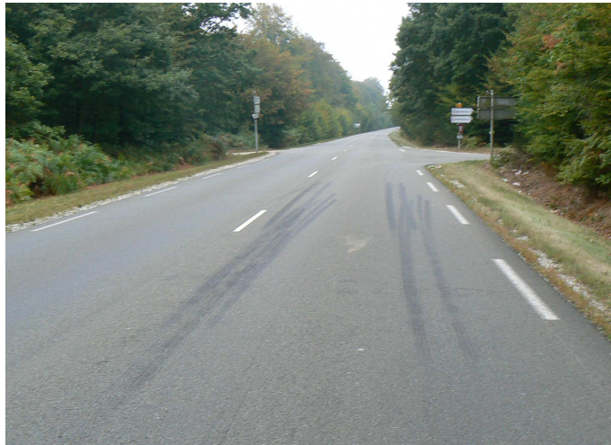
Figure A1-1 : Avant aménagement
