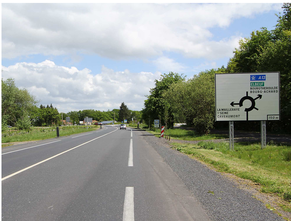
Photo 4 : Support de signalisation à sécurité passive (source département de Seine-Maritime)
