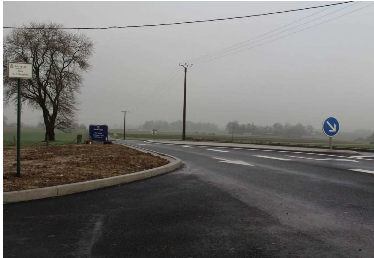
Figure A2-1 : Le diable se cache dans les détails ; masque à la visibilité introduit à la fin des travaux
