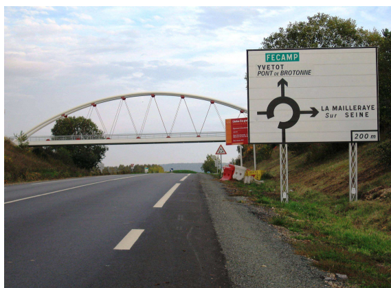
Figures A2-3 : Le diable se cache dans les détails ; D42 sur support fusible et création d'un obstacle pour la communication sur les travaux en cours
