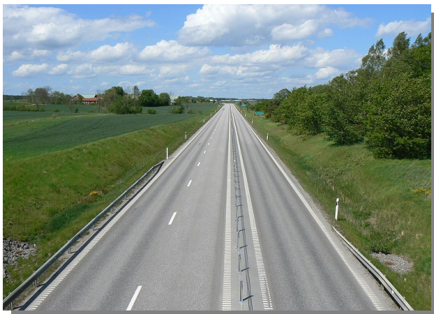
Illustration 6: Route à 2+1 voies (Suède) – Route nationale 36, au nord de Linköping.
