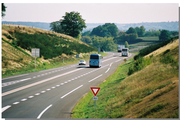
Illustration 3: Route express (RCEA - RN79), route bidirectionnelle dénivelée, isolée de son environnement.
