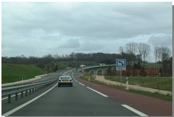
Illustration 8: Route à 2x1 voie (RN4, déviation de St Dizier)
